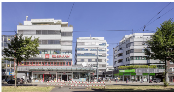
Münster Center, Düsseldorf, Deutschland, Büro-, Geschäfts- und Wohngebäude
